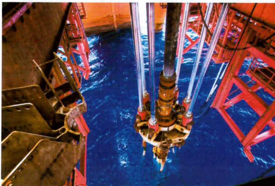
Figura 4.2 Área do Moon pool de plataforma de petróleo (drillingcontractor.org)
